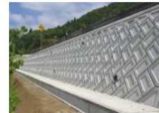
護岸ブロック
